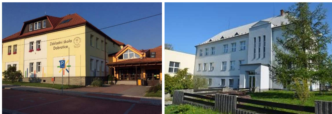
Obrázek 10: Budova základní školy Dobratice a základní školy Sedliště
